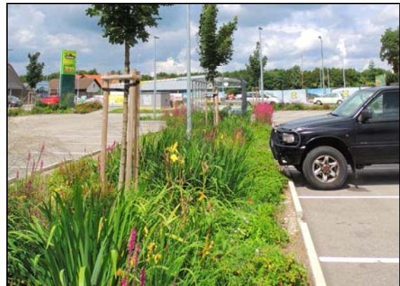
Retentionsmulden für Niederschlagswässer in einem Gewerbegebiet
