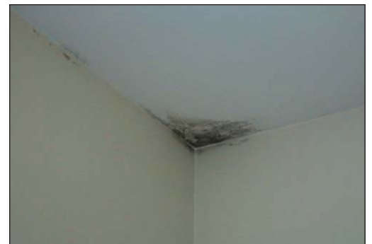
Abb. 18: Schimmelbildung linkes Bild: im Fenstersturzbereich; rechtes Bild: Raumecke, Wärmebrücke
