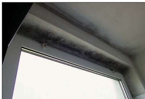
Abb. 18: Schimmelbildung linkes Bild: im Fenstersturzbereich; rechtes Bild: Raumecke, Wärmebrücke
